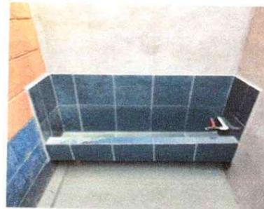
Foto 6. Se Observa la sustitución de migitorio termiando terminado.
