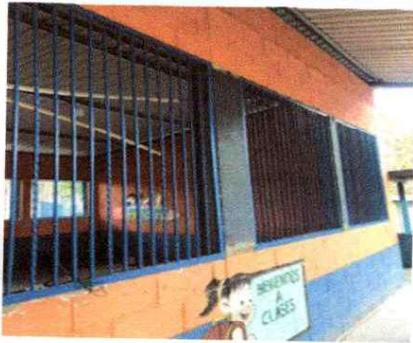
Foto 3. Se observa la malla sustuida en las ventanas por balcones terminada.
